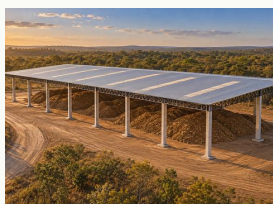
03 p. 13 Galpão para cobertura de biomassa e ampliações Jataí (GO)
