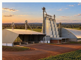
04 p. 14 Armazém graneleiro Castelândia (GO)
