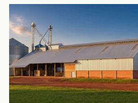
14 p. 26 Galpão rural e dependências Rio Verde (GO)
